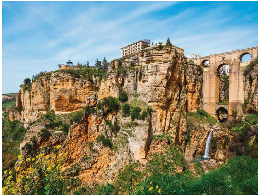
Puente Nuevo, Ronda
